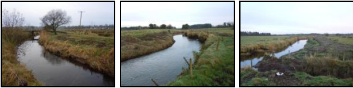
‘Tar éis na n-oibreacha’
