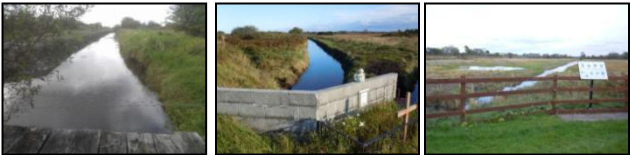
‘Tar éis na n-oibreacha’
